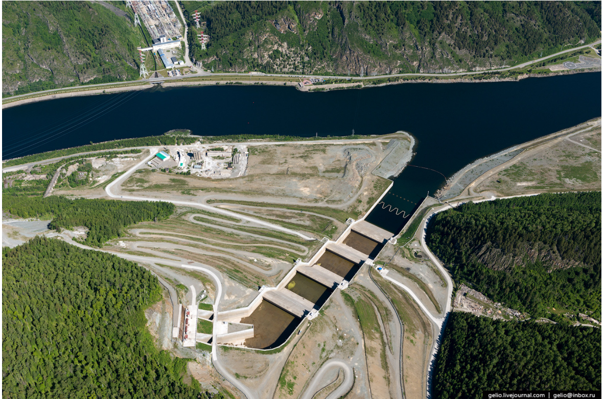
Рисунок 1.9 – Пример ступенчатого водосброса на Саяно-Шушенской ГЭС (URL: https://swalker.org/uploads/posts/2014-10/1412939468_swalker.org_008.jpg )
