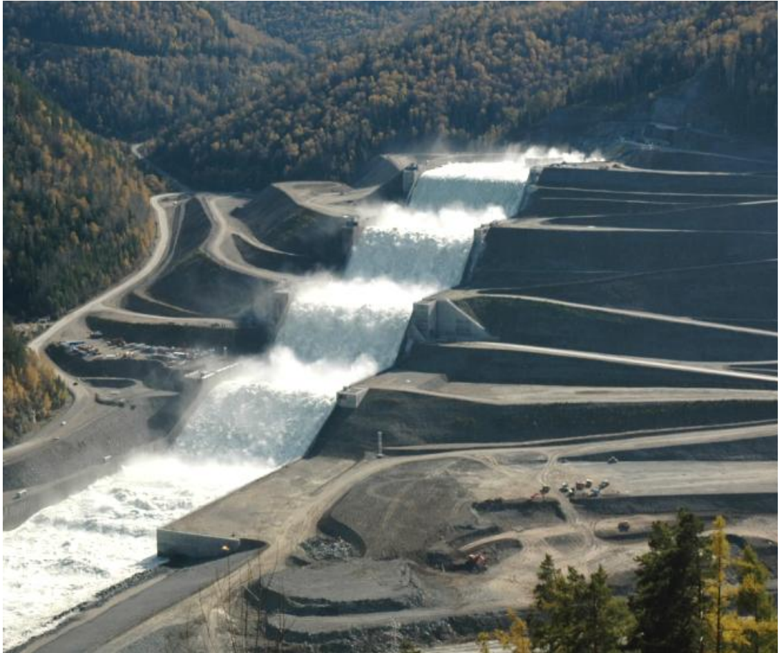
Рисунок 1.8 – Береговой ступенчатый водосброс, Саяно-Шушенская ГЭС (URL: https://swalker.org/uploads/posts/2014-10/1412939468_swalker.org_008.jpg )
